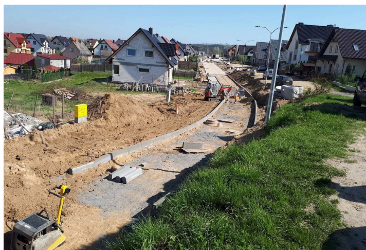
Budowa ulicy Mazowieckiej
