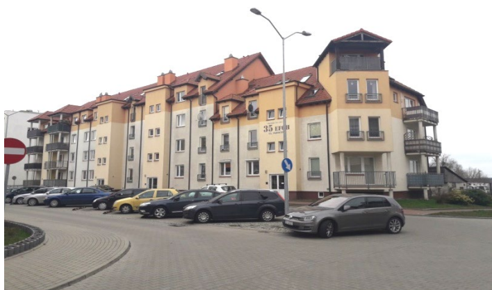
Budynek przy ul. Flisaczej 35 E-H w Gryfinie
