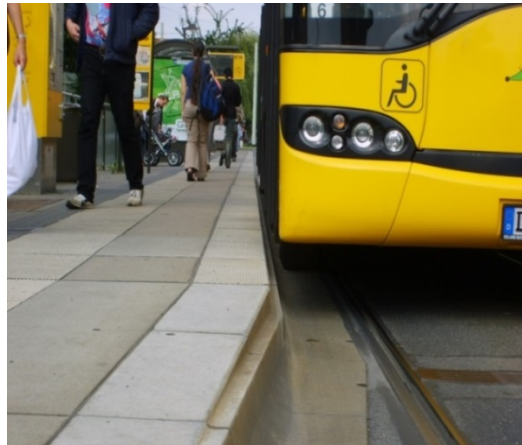
Rys. 9.7.1. Zalecane ukształtowanie krawędzi peronowej.
